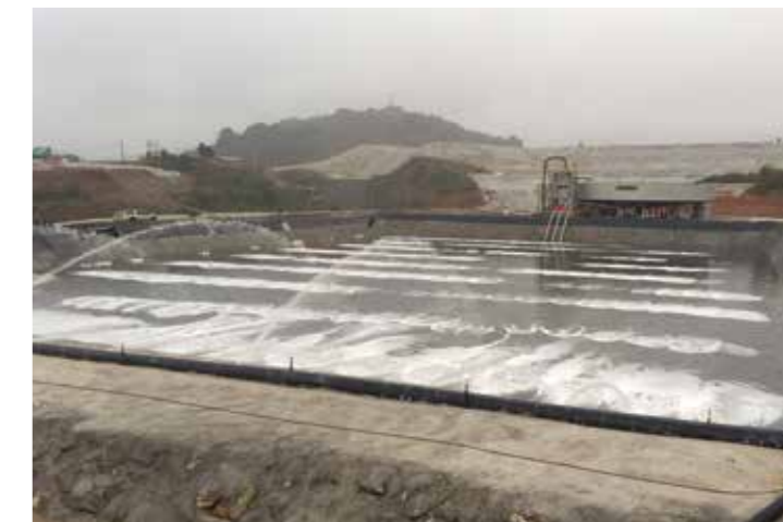
Trạm xử lý nước thải tại mỏ Núi Pháo
