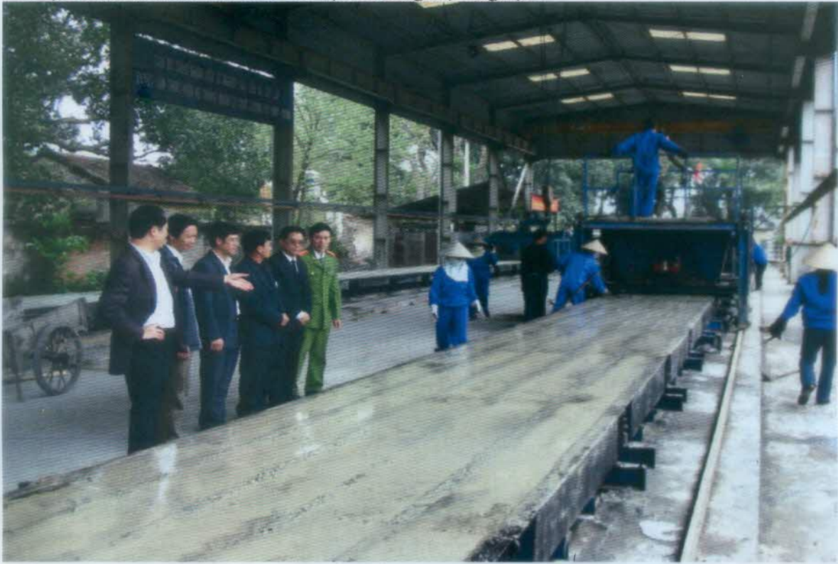
* Một số hình ảnh sản xuất Tà vẹt bê tông dự ứng lực :
