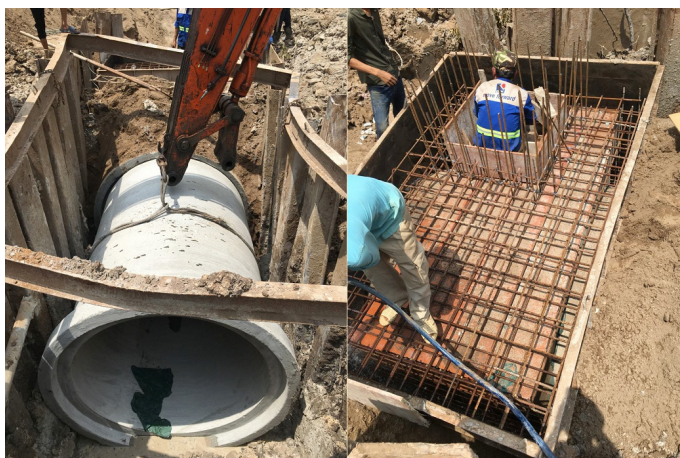
XLHN: Thi công hệ thống thoát nước cống D2000 (đoạn từ đường Alexanderod đến đường Chu Văn An)
