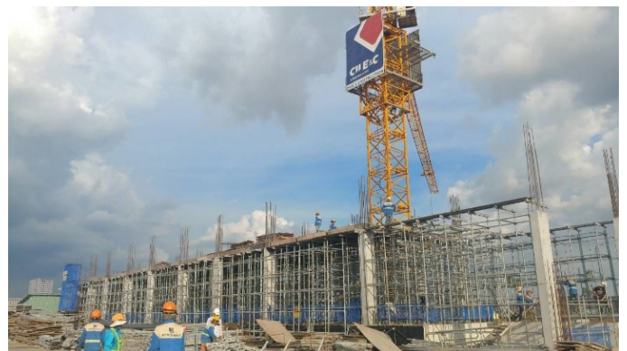
Lakeview 2: Khu 3 và 4 đang thi công cột dầm sàn tầng 2
