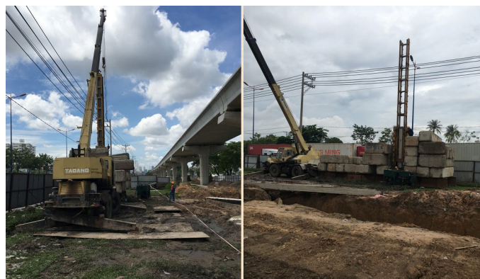
XLHN: Thi công ép cọc tại móng cầu vượt
