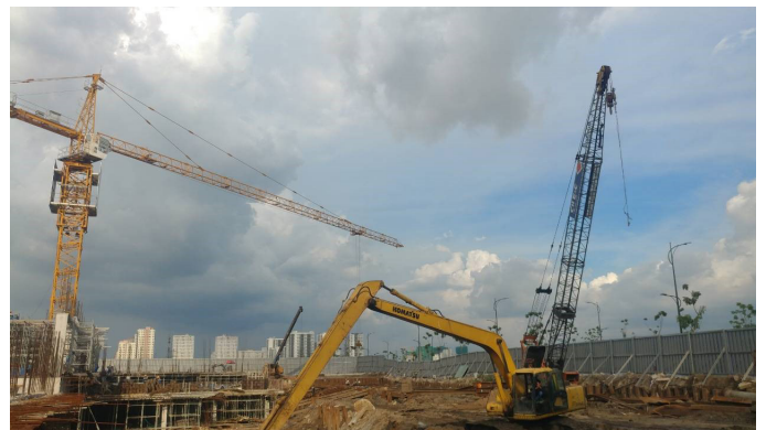
Lakeview 2: Khu 1 và 2 đang đào đất xây tầng hầm
