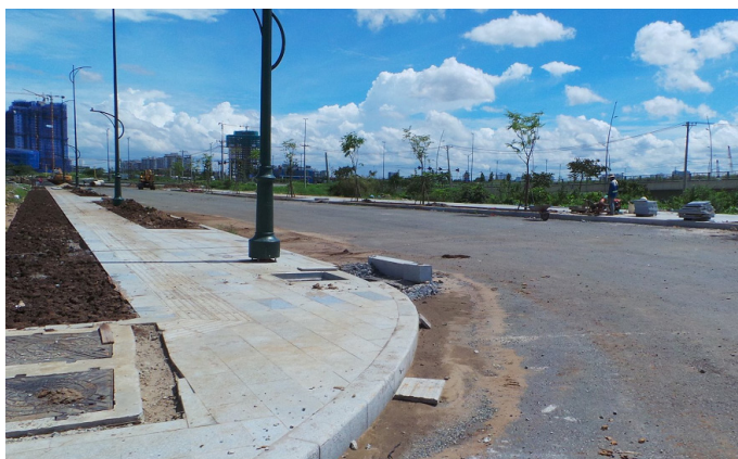
BT Thủ Thiêm: Thi công vỉa hè đường R11
