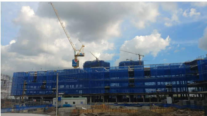
Lakeview 1: Khu nhà 4 tầng đã hoàn thành thi công phần thân, đang xây dựng tường căn hộ
