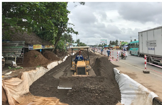
QL60: Đắp cát nền đường trái tuyến
