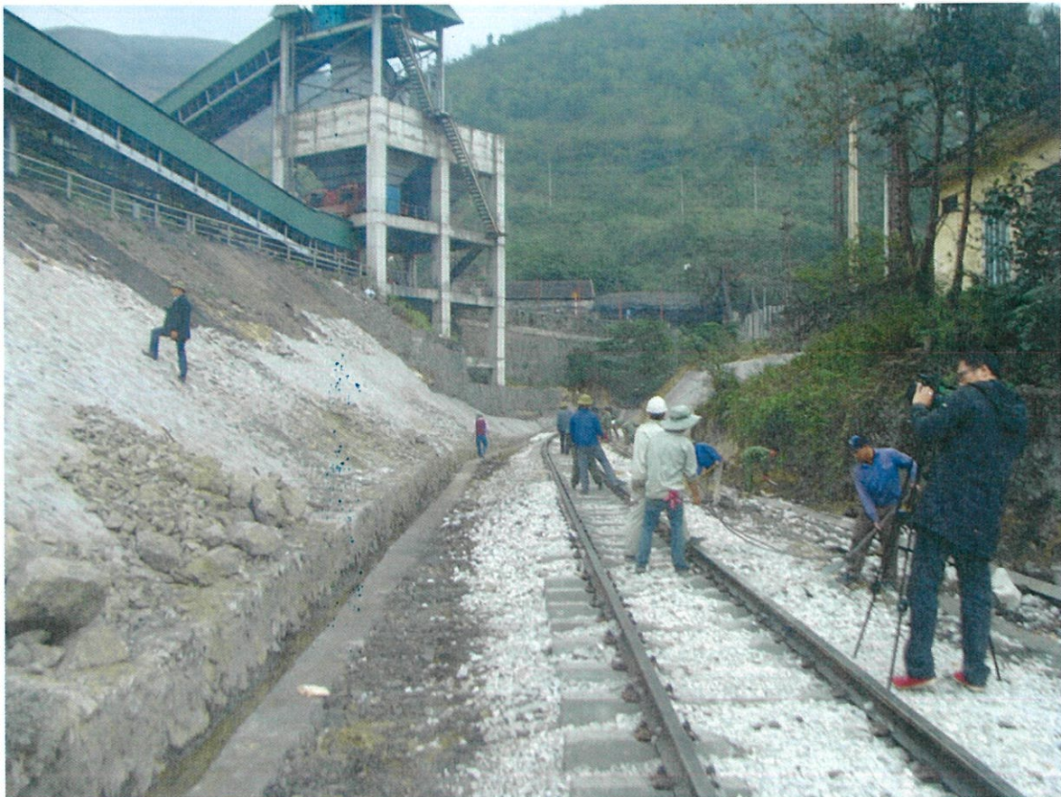
* Hình ảnh thi công công trình đường sắt trên cao Cát Linh Hà Đông 2016:
