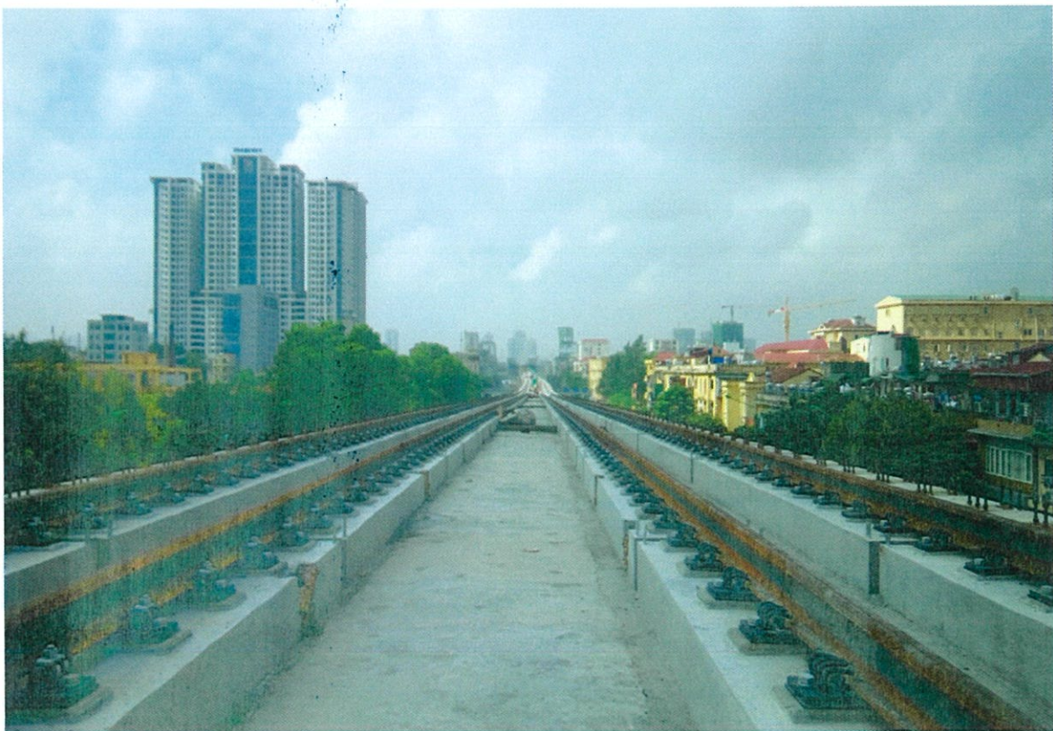
* Hình ảnh sản xuất Tà vẹt bê tông dự ứng lực tại Cổ Loa Đông Anh :
