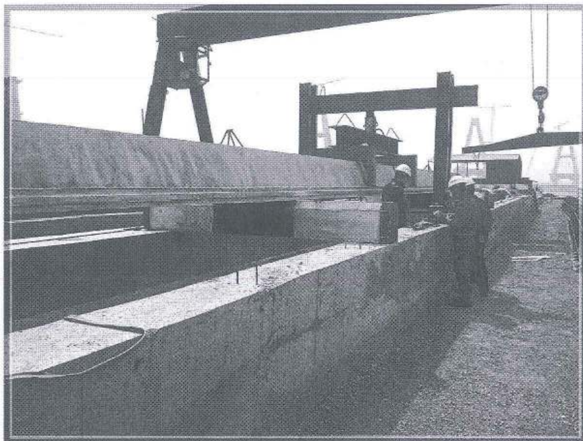
Thiết bị sản xuất cấu kiện bê tông đúc sẵn
