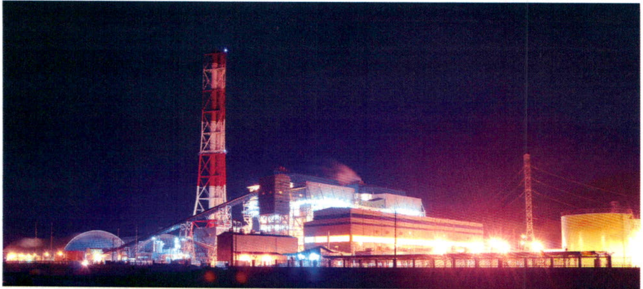
Nhà máy nhiệt điện Nghi Sơn 1 – Thanh Hóa
