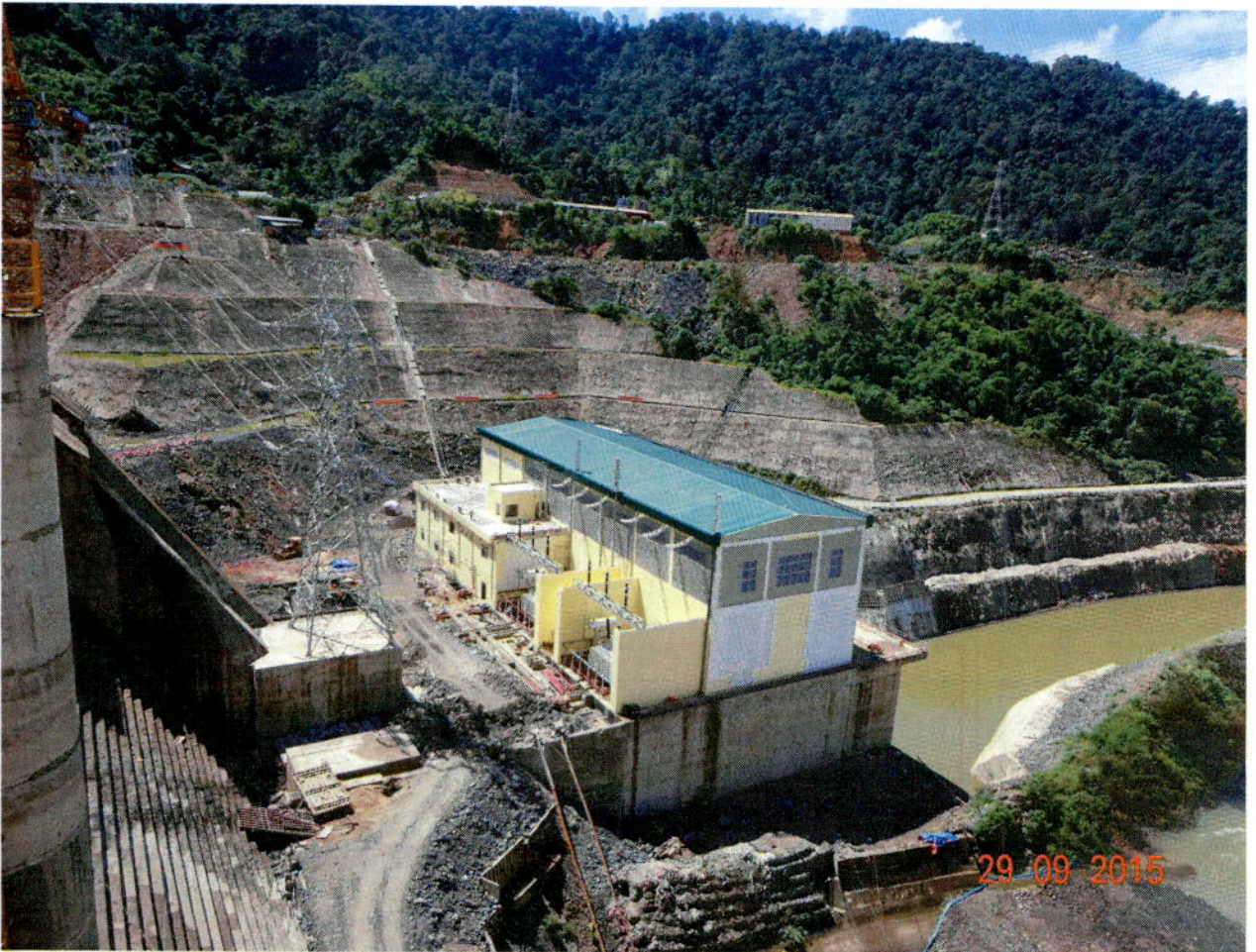
Nhà máy thủy điện Đồng Nai 5
