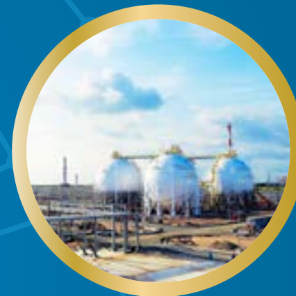
CÔNG TRÌNH CÔNG NGHIỆP
