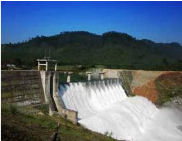
Đập tràn piano do TV2 thiết kế, công trình thủy điện Đak Mĩ 4B
