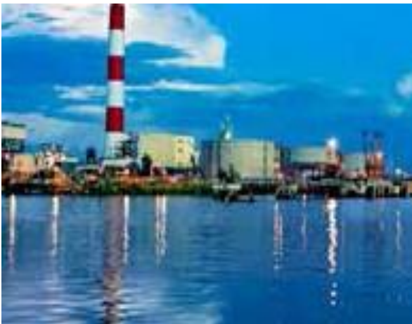
NMNĐ Ô Môn (2x330MW), TV2 phối hợp với TEPCO làm tư vấn chính
