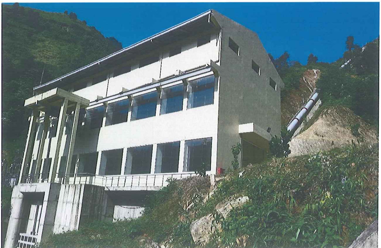
Nhà máy thủy điện Bắc Nà - Nguồn: CTCP Sông Đà 505
