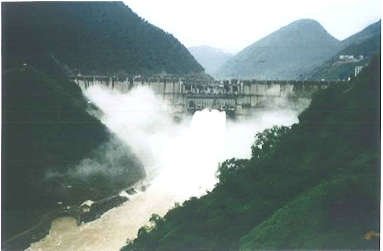
Nhà máy thủy điện KrôngK'ma - Nguồn: CTCP Sông Đà 505
