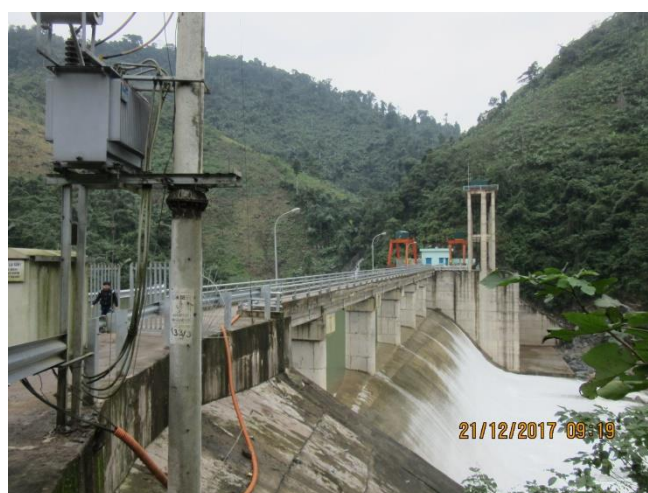
Đập dâng NMTĐ Đa Krông 1
