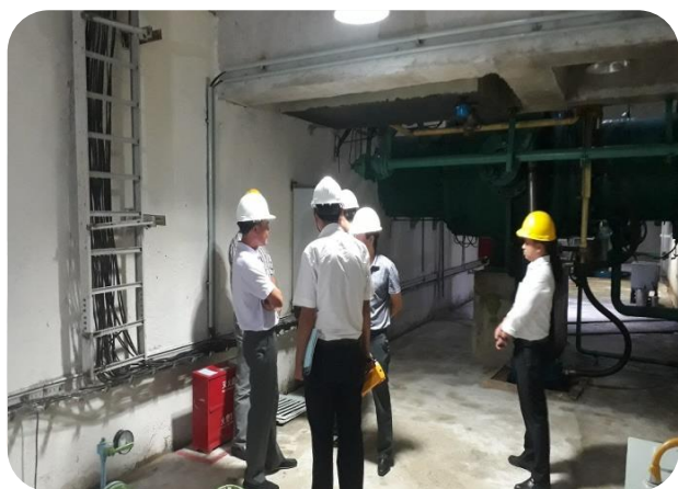
Đoàn Thanh tra Bộ TNMT kiểm tra bể chứa nước tại NMTĐ Đắk Pônê
