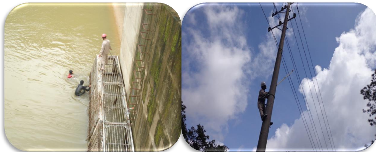
Công tác vớt rác, sửa chữa đường dây NMTĐ Đắk Pônê
