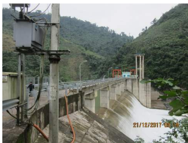
Đập dâng NMTĐ Đa Krông 1
