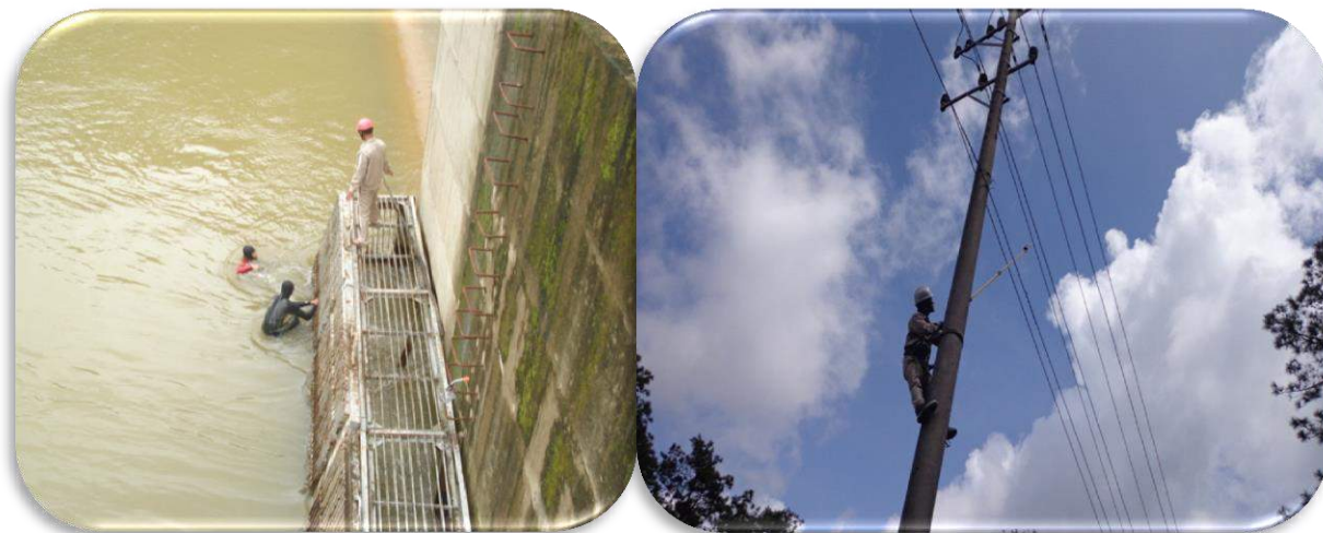
Công tác vớt rác, sửa chữa đường dây NMTĐ Đắk Pône
