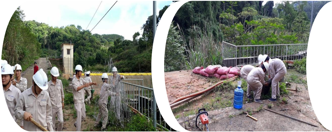
Công tác triển khai rọ đá, chuẩn bị đắp bờ ngăn
