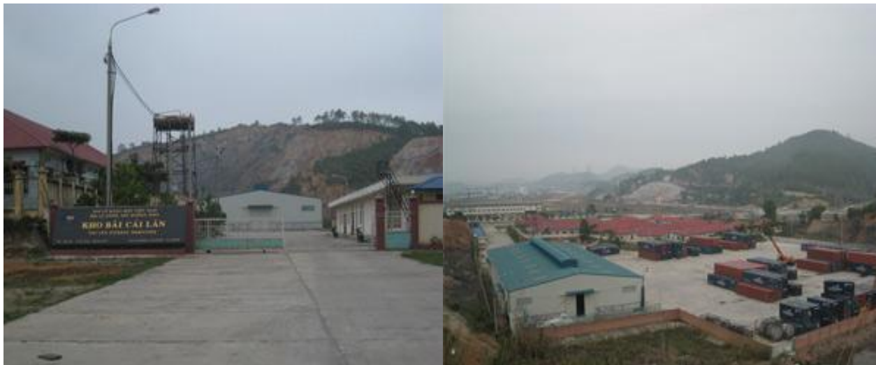
Một số hình ảnh: Khai thác kho, bãi VOSA Quảng Ninh tại Cái Lân.
