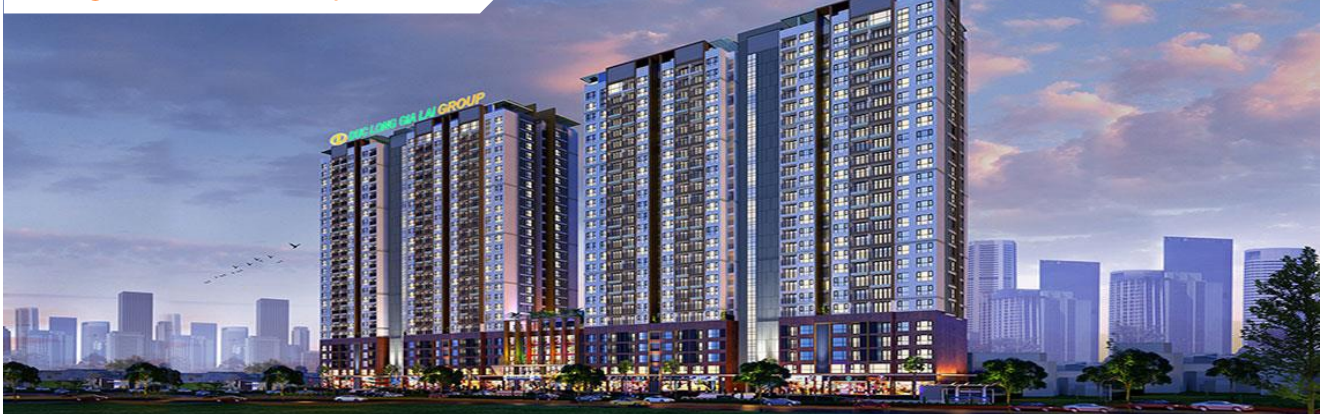
Công trình Sunshine Apartment
