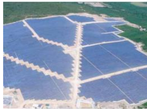
Nhà máy điện mặt trời Krong Pa Địa điểm: tỉnh Gia Lai
