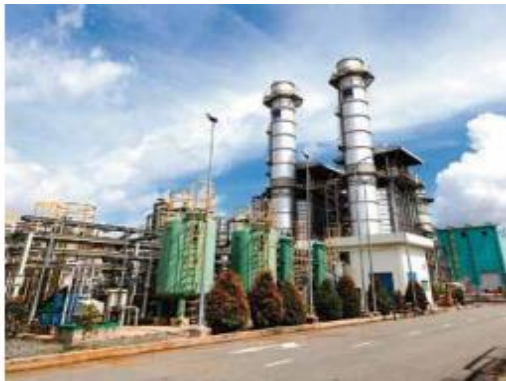
Nhà máy Nhiệt điện Nhơn Trạch 1 Địa điểm: tỉnh Đồng Nai
