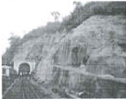
Thi công đường sắt địa chủ Hà Tĩnh bằng công nghệ phân bố ứng lực Technology
