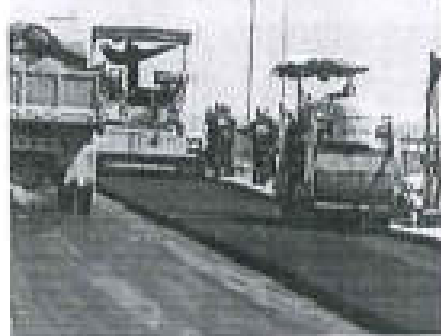
Thi công đường tránh thành phố Huế, Dự án đường tránh thành phố Huế Construction of the bypass road of Hue city, Hue city bypass road project
