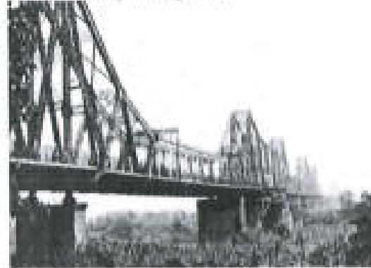
Giàn cố cầu Long Biên, TP. Hà Nội Consolidation of Long Bien Bridge, Ha Noi
