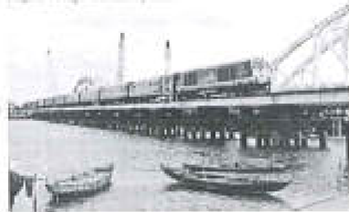
Thi công các công trình thuộc gói thầu CP2 dự án nâng cấp các cầu yếu trên tuyến đường sắt Thống Nhất Construction of Bridges of CP2 Package, Upgrade Safety Improvement Project, Thống Nhất Railway Line
