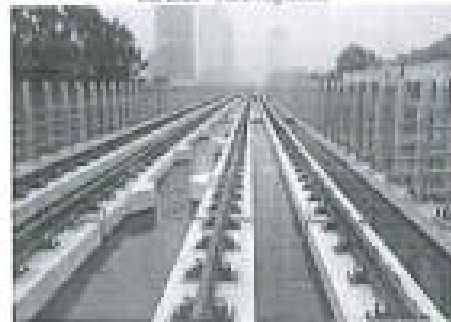
Thi công đường sắt, Dự án Đường sắt đô thị thành phố Hà Nội Tuyến Cát Linh – Hà Đông Railway Construction, Hanoi Urban Railway Project Cát Linh – Hà Đông Route
