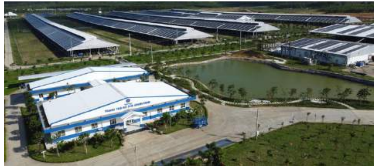
Hình ảnh trang trại sinh thái Green Farm Quảng Ngãi đã lắp đặt Hệ thống năng lượng mặt trời
