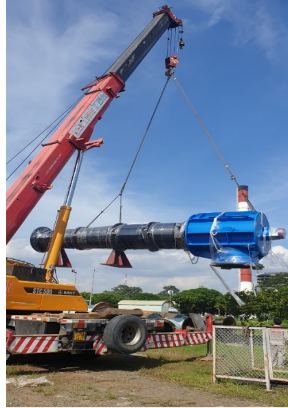
Ảnh: Bơm tuần hoàn – Nhà máy Nhiệt điện Thủ Đức
