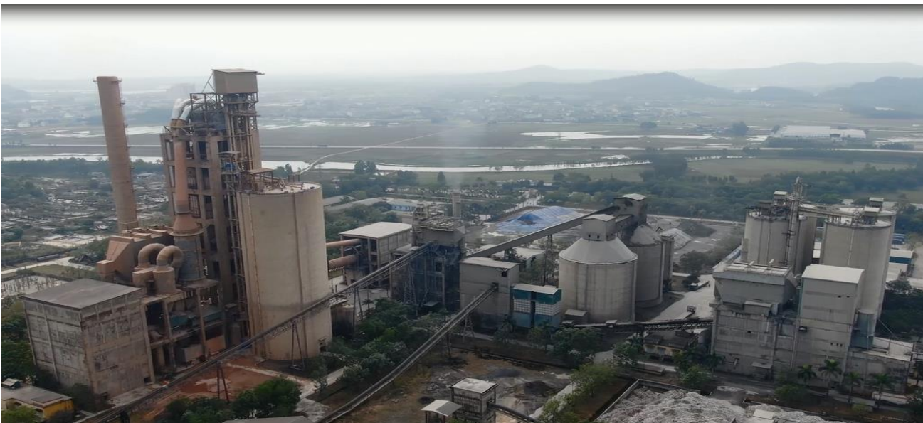
CẢI TẠO NÂNG CẤP THAY THẾ 4 CYCLONE C1 VÀ TOÀN BỘ GHI 1 SANG THỂ HỆ MỚI
