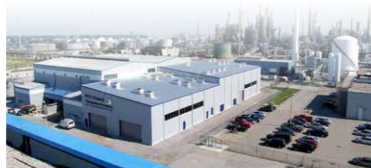
H.C. Starck Canada - Nhà máy Samta
