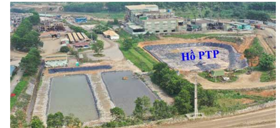
Hoàn thành lót chống thấm hồ PTP
