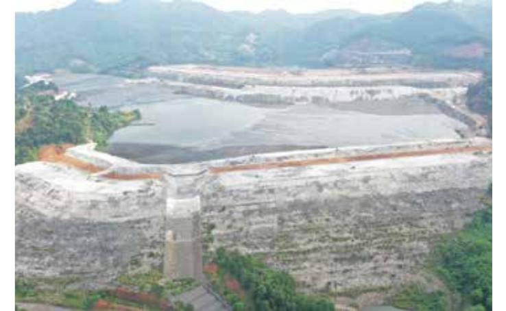
Sử dụng đất đá thải để đắp đập hồ chứa đuôi quặng OTC và STC
