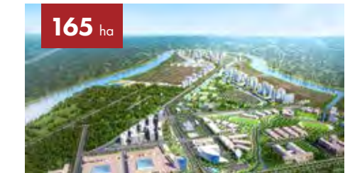
165 ha WATERPOINT GIAI ĐOẠN 1 📍 Bến Lức, Long An
