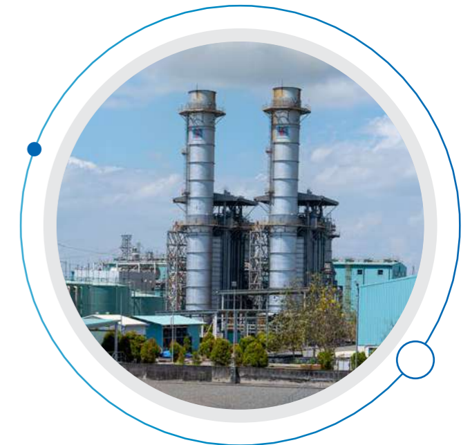
Công ty Điện lực Dầu khí Nhơn Trạch - Nhà máy Điện Nhơn Trạch 1
