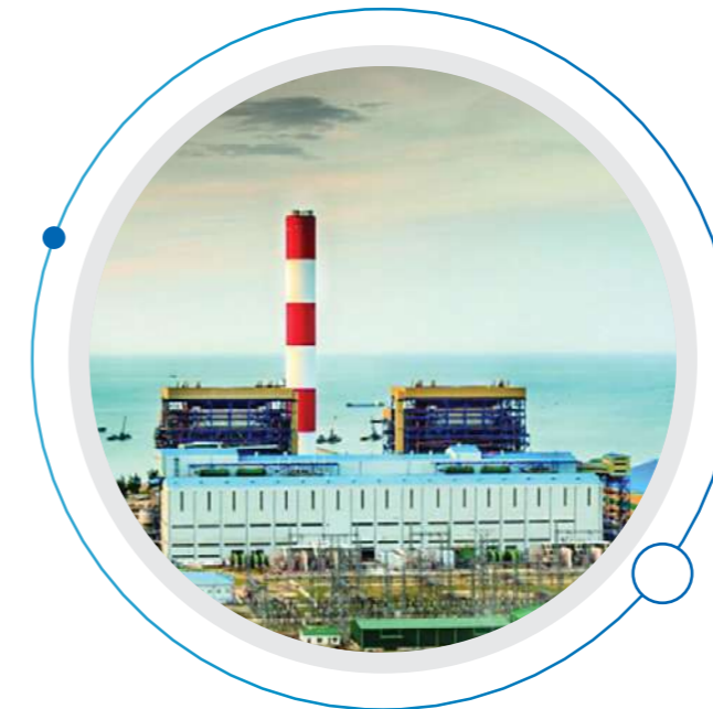
Công ty Điện lực Dầu khí Hà Tĩnh - Nhà máy Điện Vũng Áng 1
