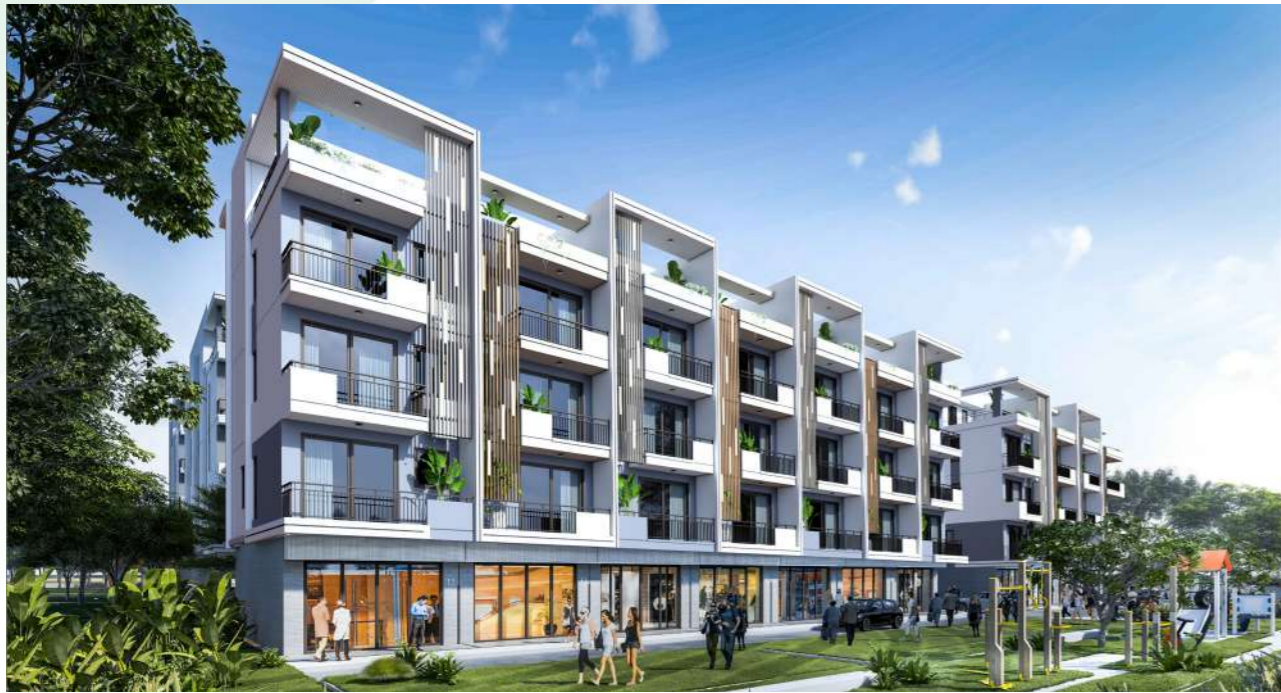
Hình ảnh Dự án PCC1 Gia Lâm
