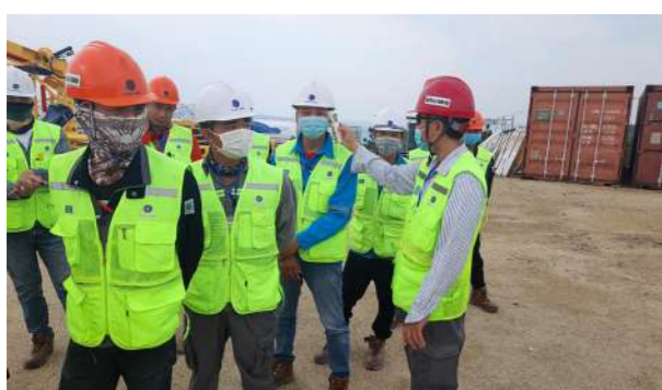
Hình ảnh phòng tại công trường điện gió
