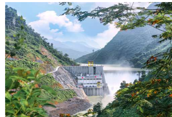
Nhà máy Thủy điện Bảo Lâm 3
