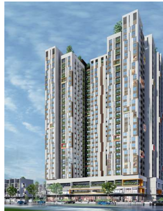
Hình ảnh Dự án PCC1 Thăng Long
