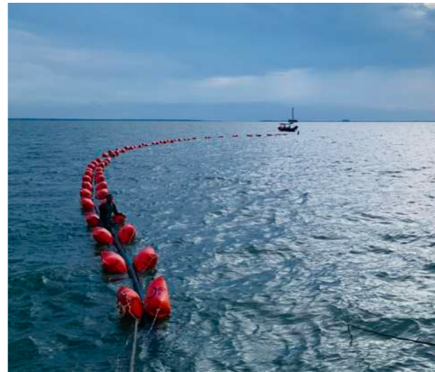
PC1 Group rải cáp thi công lắp đặt hệ thống cáp ngầm biển, NMĐG Tân Phú Đông, Tiền Giang
