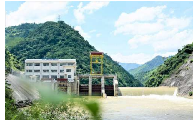
Nhà máy Thủy điện Bảo Lâm 3A
