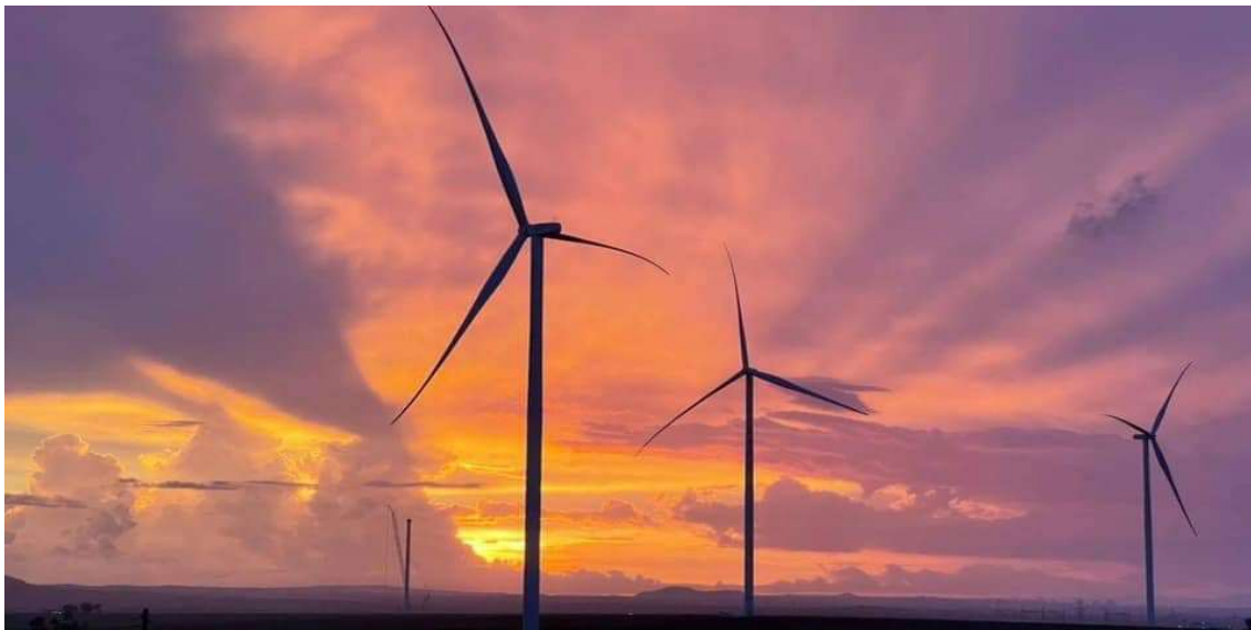
Nhà máy Điện gió Ia Pét Đăk Đoa 1, 2 (khánh thành ngày 14/01/2022)
