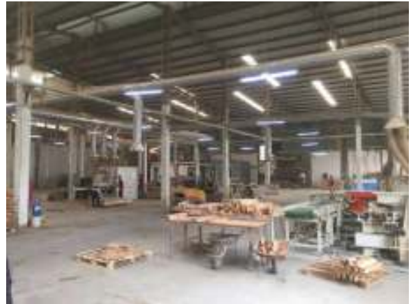
Hệ thống hút bụi hiện đại
