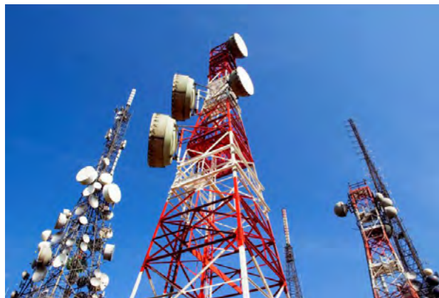
Xây lắp Hạ tầng viễn thông
