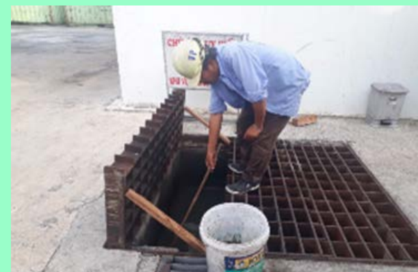
Vệ sinh, nạo vét rãnh nước, hố ga thu nước
