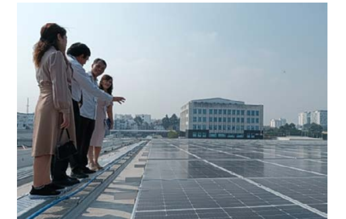
Công trình điện mặt trời mái nhà SCSC - CMES công suất 1,1 Mwp
