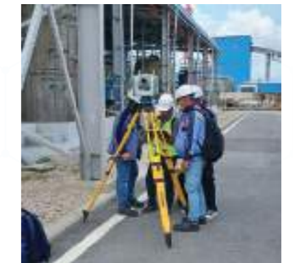
Đội ngũ kỹ thuật DCC thực hiện công tác Scan to BIM tại sân phân phối Dự án Nhà máy Nhiệt điện Vĩnh Tân 4
