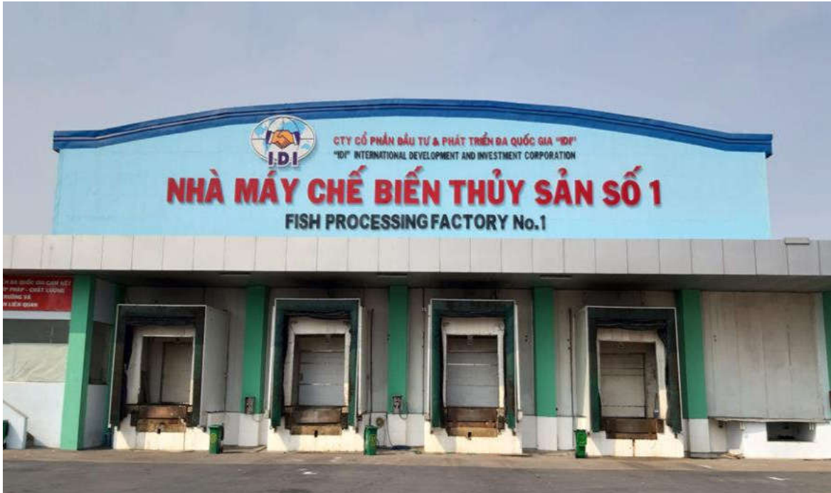
Nhà máy đông lạnh số 1 đang hoạt động với công suất là 300 tấn nguyên liệu/12 giờ/ngày
