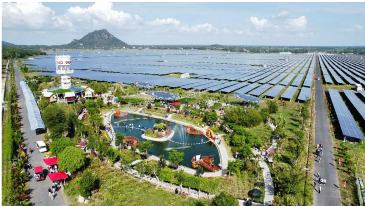
Toàn cảnh dự án Khu du lịch điện mặt trời An Hào
