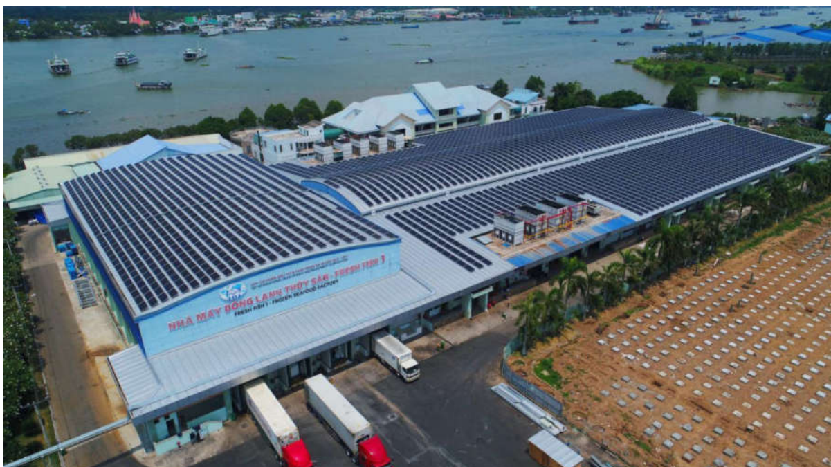
Hệ thống điện mặt trời của Nhà máy đông lạnh thủy sản số 1 do Tập đoàn Sao Mai lắp đặt
