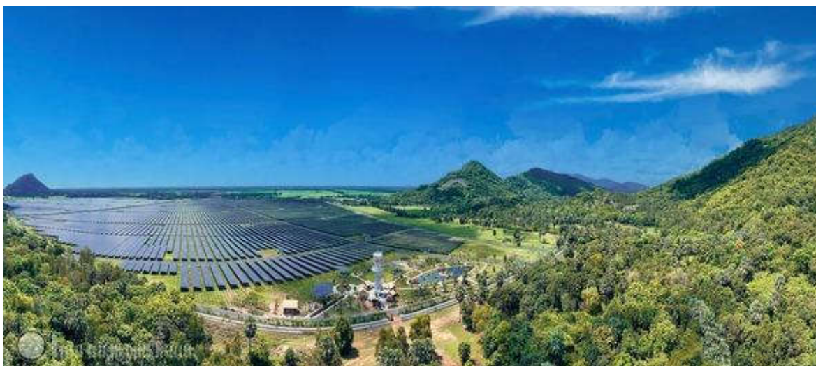
Toàn cảnh dự án Điện mặt trời Sao Mai 210Mwp tại xã An Hào, huyện Tịnh Biên, An Giang
