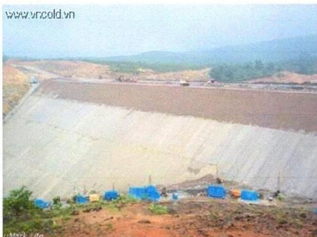
**Thủy điện Quảng Trị :** Tổng thầu xây lắp, trực tiếp thi công đập chính và tràn xả lũ (2003-2007). Nhiệm vụ chính của công trình là điều tiết nước phục vụ tưới 12.281ha lúa, 1.600ha hoa màu, cấp nước sinh hoạt cho hạ lưu, giảm lũ cho hạ lưu và phát điện với công suất lắp máy 70MW, điện lượng trung bình hàng năm 260,52 triệu KWH. Đập chính là đập đá đổ bản mặt bê tông cốt thép lần đầu xây dựng tại Việt Nam.
