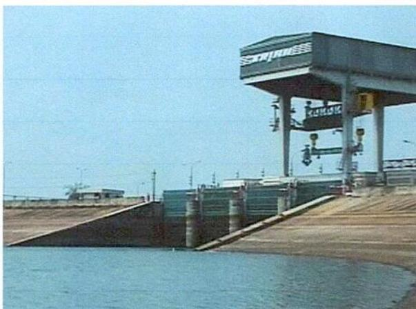
**Thủy điện Trị An – Đồng Nai :** Thi công toàn bộ tuyến áp lực và ½ cửa nhận nước (1984-1987). Đập chính là đập đất đá hỗn hợp có chiều dài 420m, đập tràn là đập bê tông trọng lực, chiều dài 150m với 8 khoang tràn x 15m. Nhiệm vụ chính của công trình là phát điện công suất lắp máy 400MW, điện lượng trung bình hàng năm 1,7 tỷ KWH, cải thiện lưu lượng nước sông Đồng Nai vào mùa khô.
