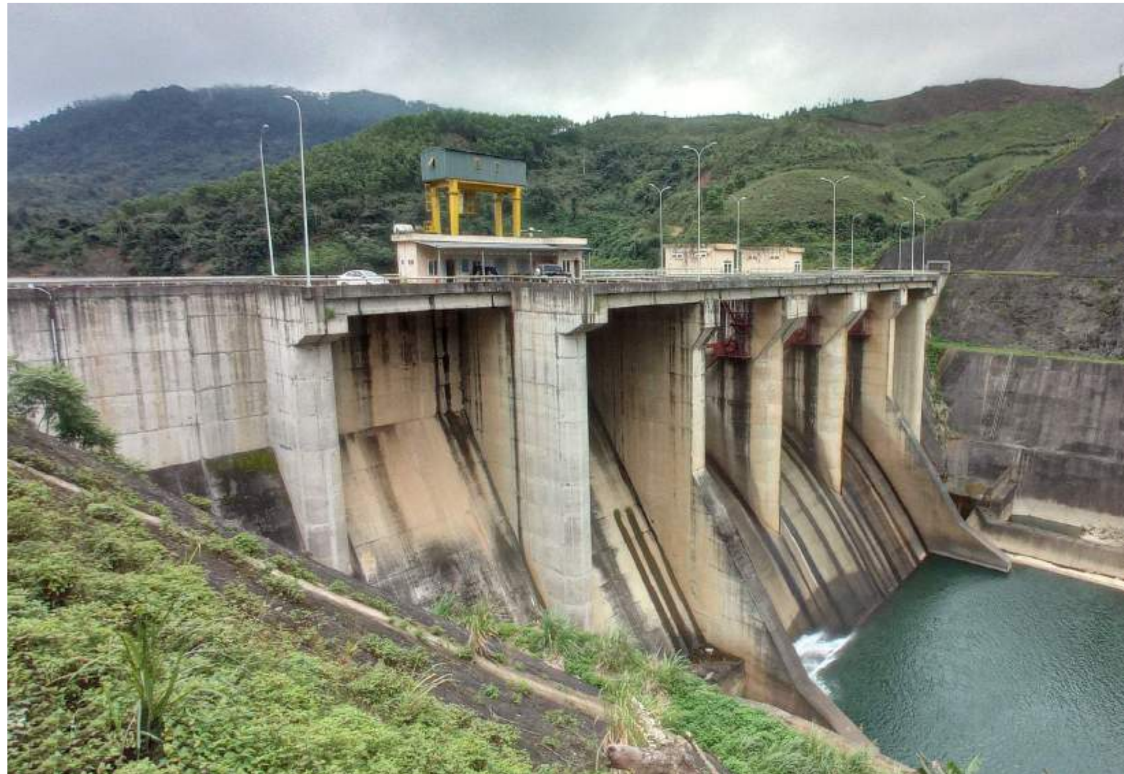
Đập tràn Nhà máy thủy điện A Lưới
