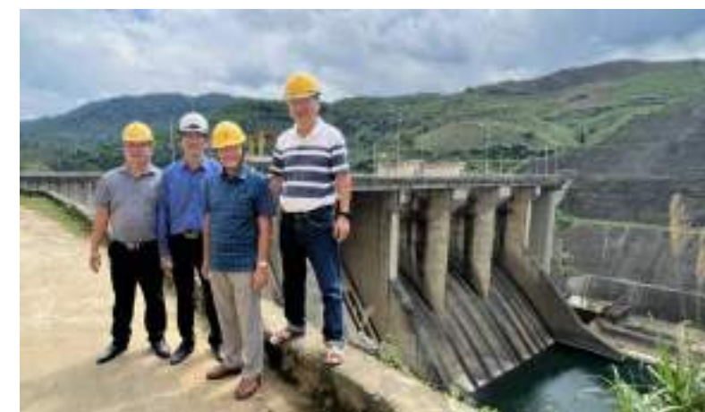
HĐQT kiểm tra hoạt động SXKD tại Nhà máy thủy điện A Lưới
