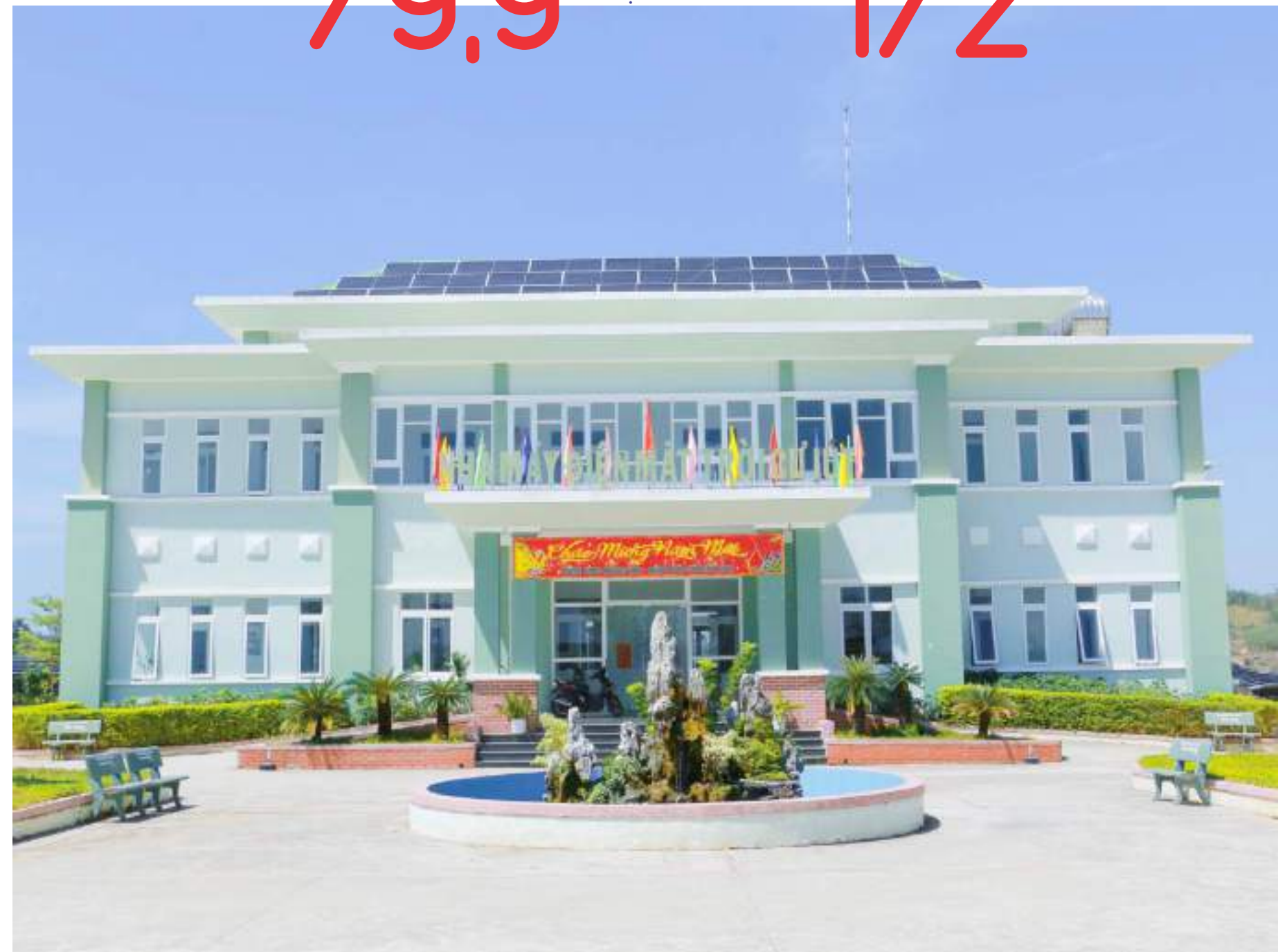
Nhà máy Điện mặt trời Cư Jút
