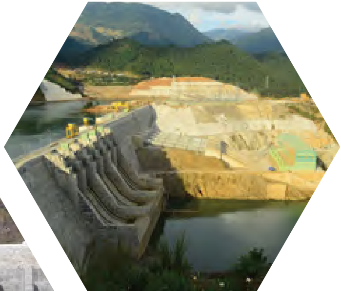
Thủy điện Trung Sơn
