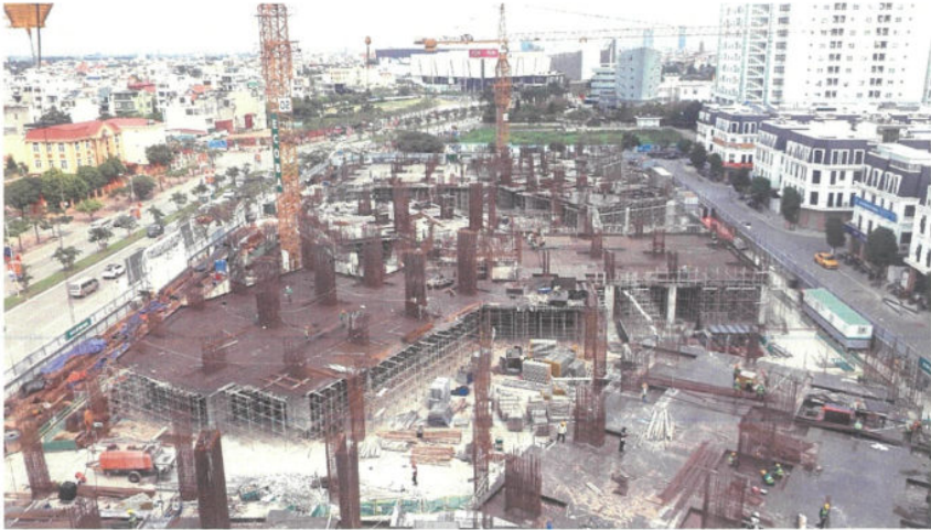
Tiến độ thi công thực tế tại dự án Hoang Huy Commerce (tòa H1) vào tháng 6/2022
