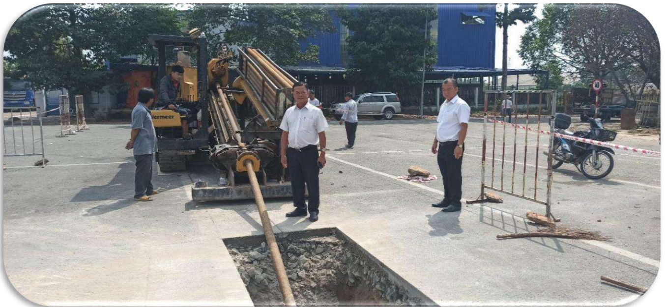
Sử dụng robot đặt ống ngầm thay cho đào đường tại công trình nâng cấp nhà máy cấp nước Đất Cuốc
