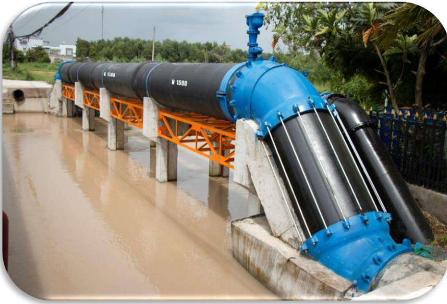
Tuyến ống nước thô Tân Hiệp D1500mm
