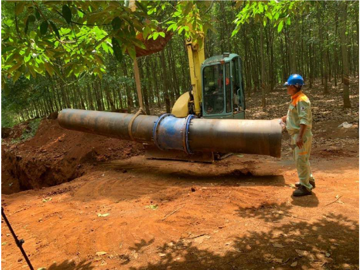
Cấp nước Gia Tân thi công lắp đặt thêm nhiều tuyến ống
