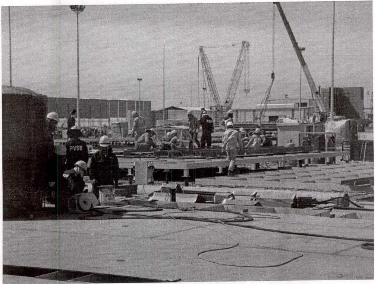
(Công nhân SMBĐ thi công chế tạo và lắp đặt các công trình cơ khí dầu khí đảm bảo an toàn)
