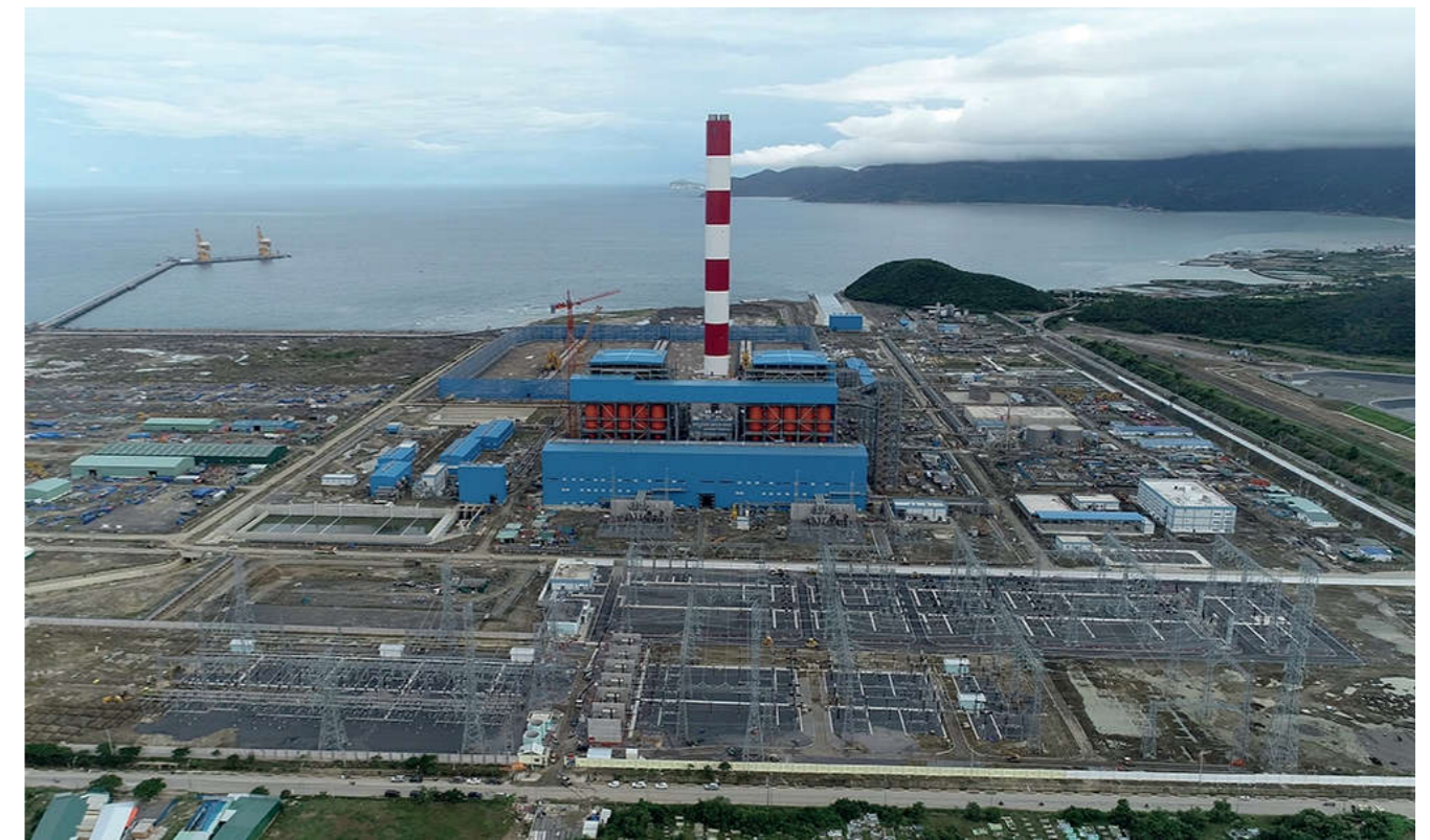
TBA 500kV Vân Phong
