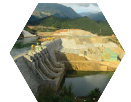
Thủy điện Trung Sơn
