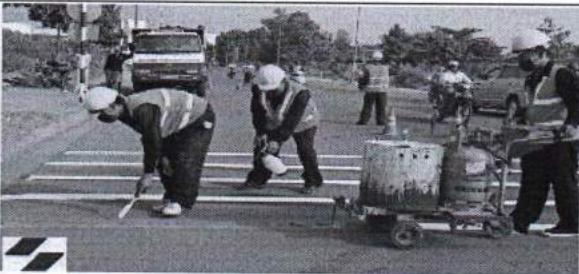
Duy tu đường, mương cống thoát nước
