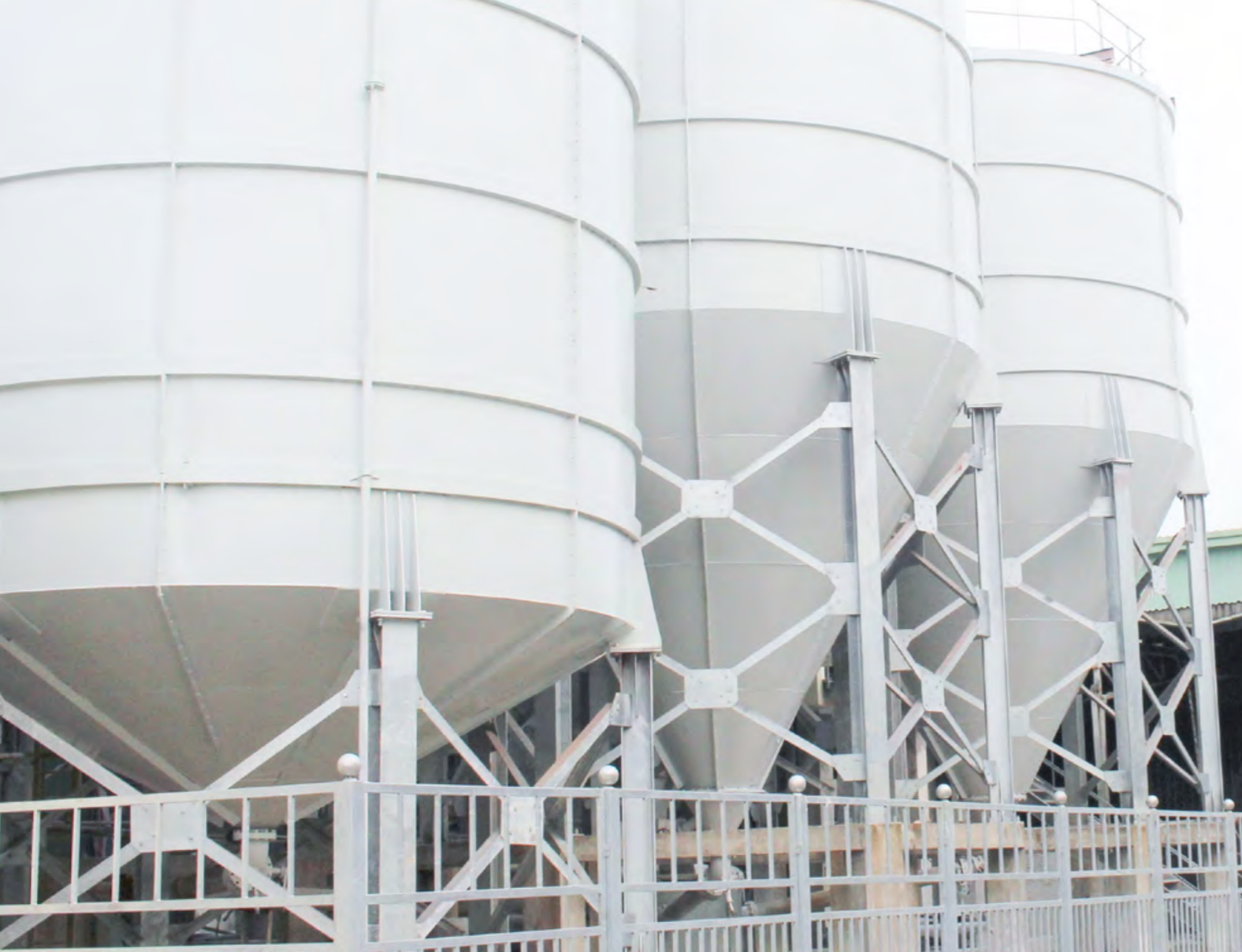
Hệ thống silo nước tuần hoàn trong khuôn viên Công ty
