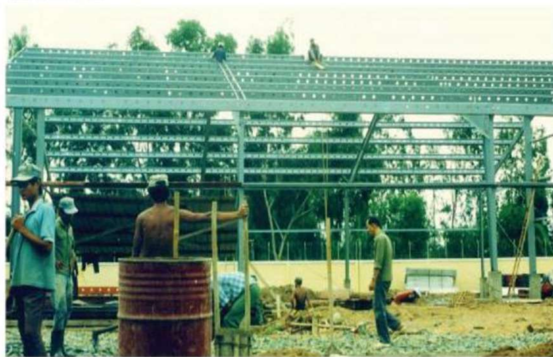
Khởi công xây dựng nhà máy
