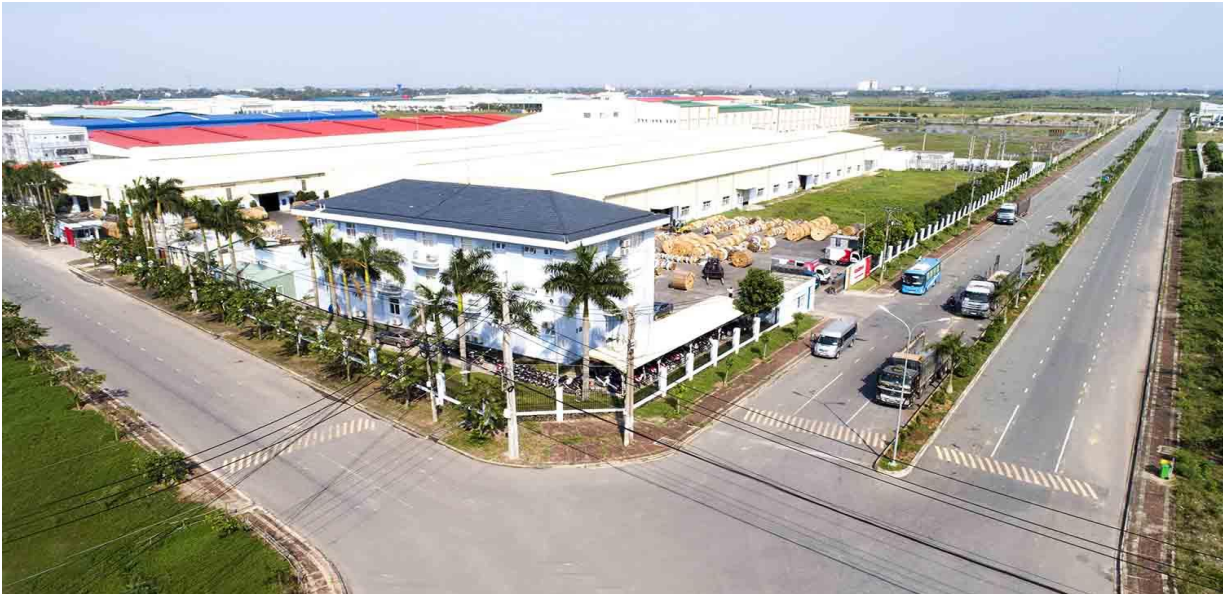
KCN Tân Phú Trung với hạ tầng hoàn thiện
