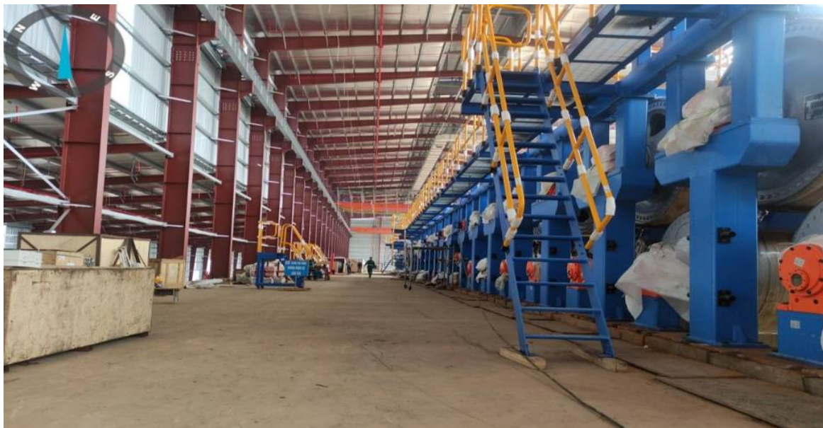
Lắp đặt dây chuyền Xeo giấy tại tầng 2 nhà xưởng chính của Dự án
