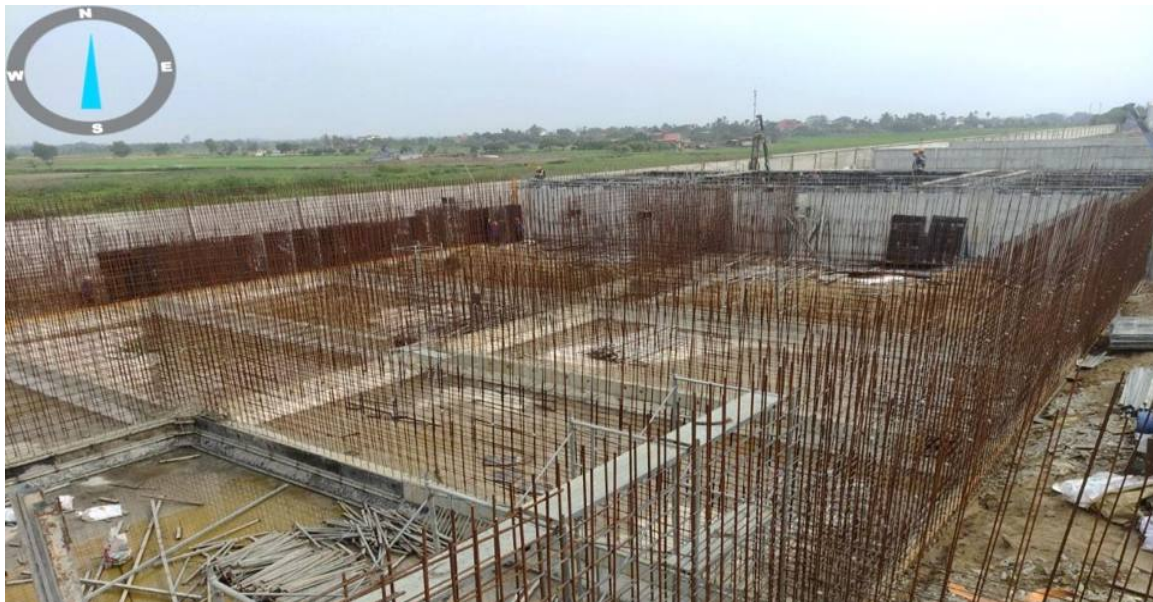
Thi công Hệ thống xử lý nước thải
