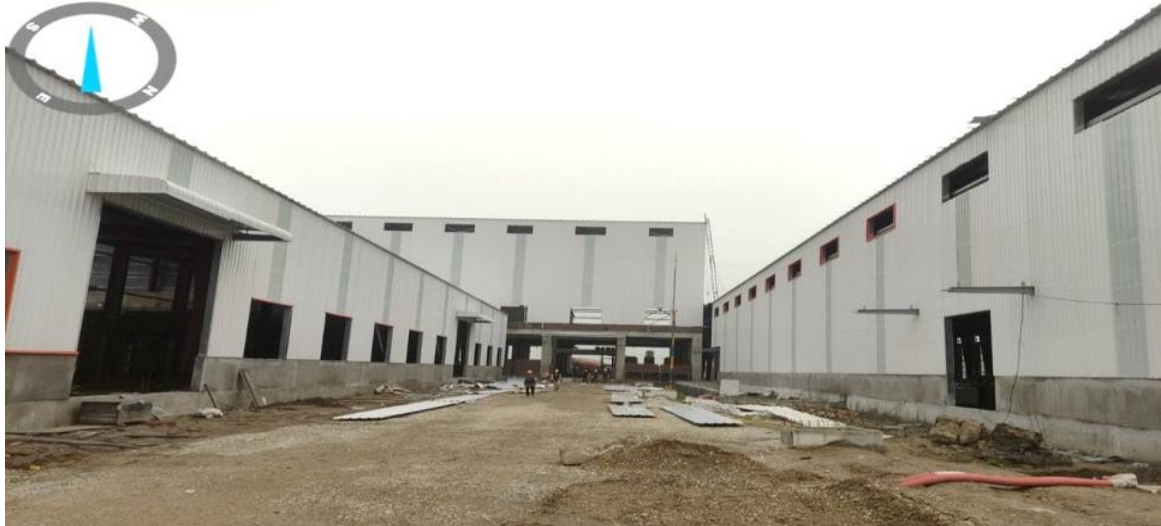
Thi công hoàn thiện các nhà xưởng
