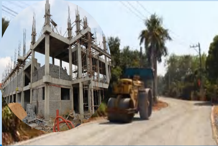
Thi công công trình dân dụng và đường bộ
