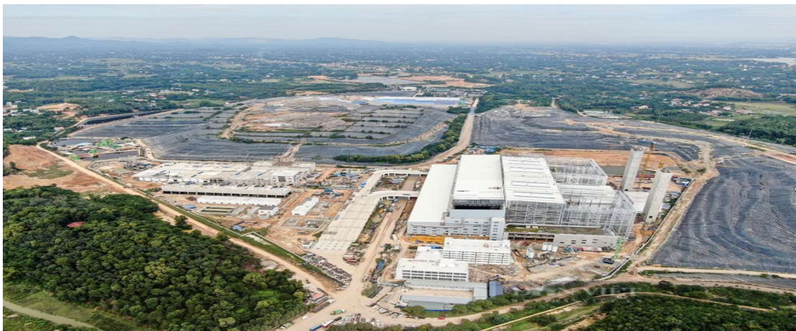
Nhà máy nhiệt điện rác Sóc Sơn
