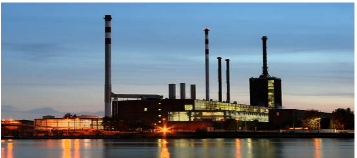
Nhà máy nhiệt điện Thái Bình 2
