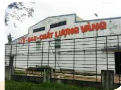
7. KHO TỒN TRỮ VÀ NHÀ MÁY CHIẾT NẠP TẠI VŨNG TÀU
