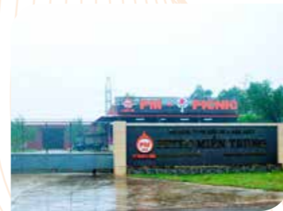
8. KHO TỒN TRỮ VÀ NHÀ MÁY CHIẾT NẠP TẠI QUẢNG TRỊ
