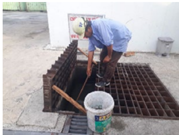
Vệ sinh, nạo vét rãnh nước, hố ga thu nước
