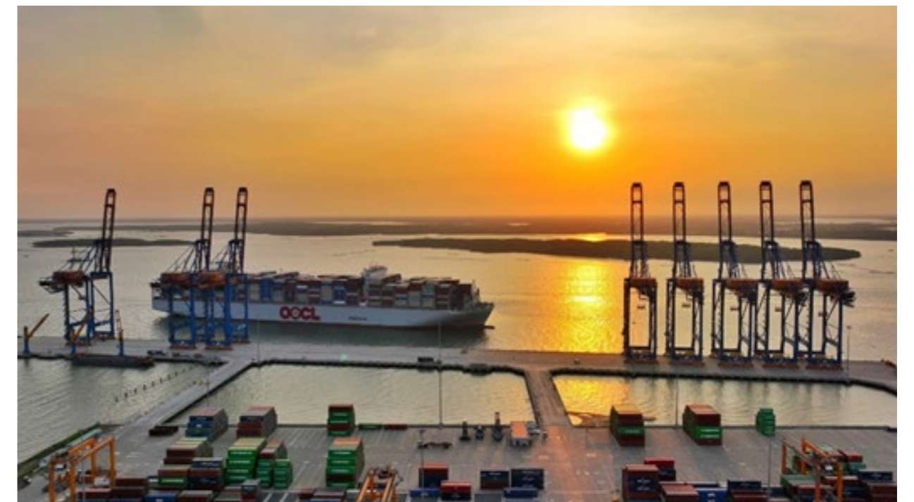
Độ sâu trước bến tại cảng Gemalink đạt -16.5 mét đủ điều kiện đón Siêu tàu container OOCL SPAIN lớn nhất thế giới
