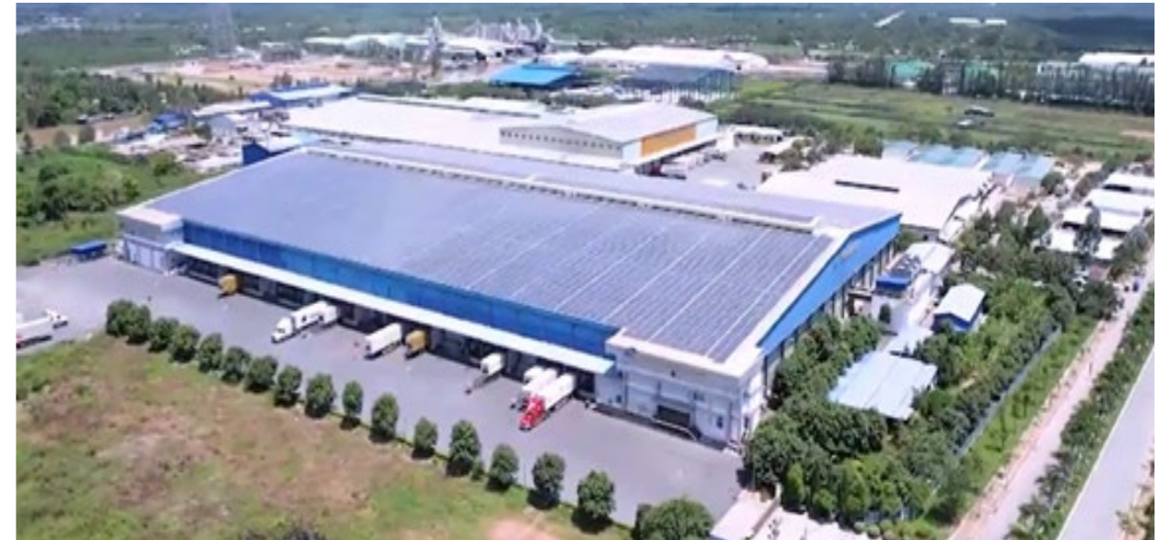
Điện áp mái tại kho Mekong Logistics cung cấp sản lượng điện lớn cho vận hành từ năng lượng mặt trời
