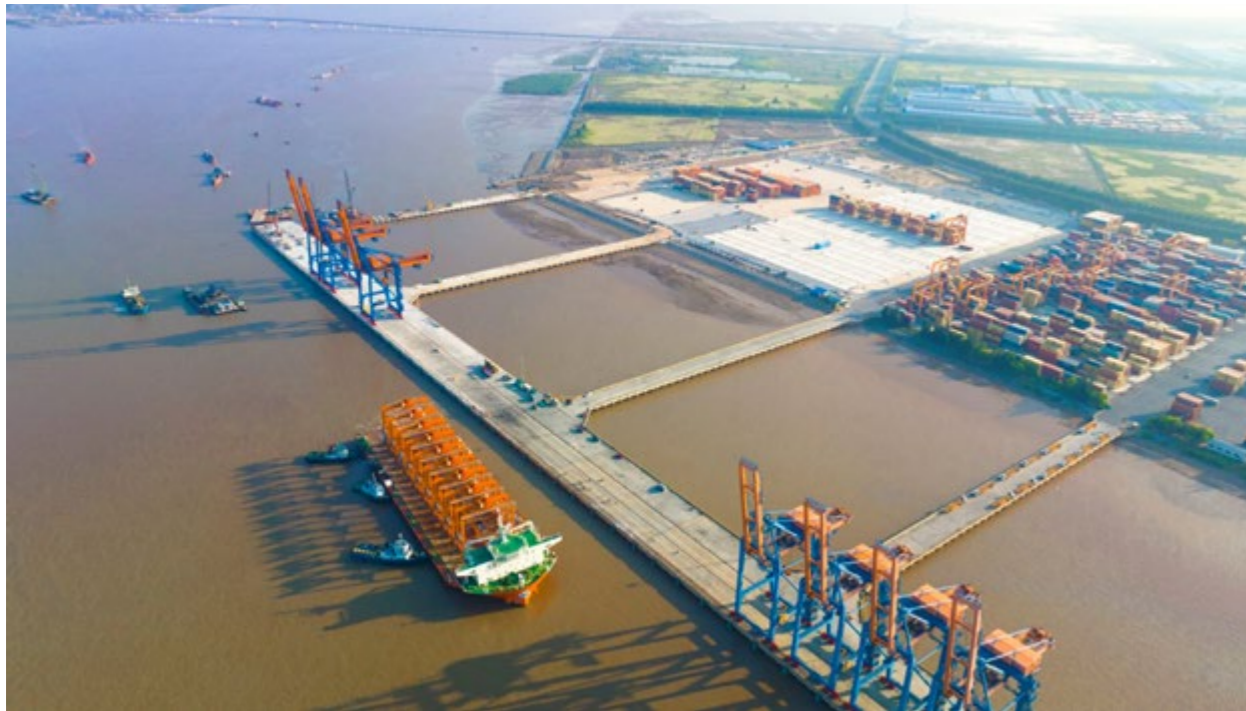
Tất cả thiết bị cầu RTG của Cảng Nam Đình Vũ đều chạy điện 100%
