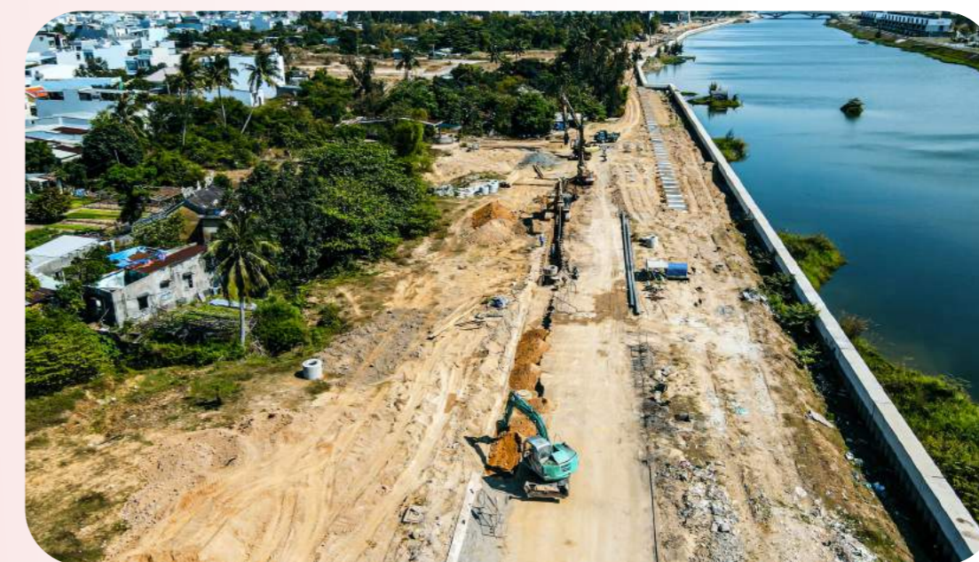
Dự án Hệ thống xử lý nước thải lưu vực Sông Cổ Cò - Đà Nẵng
