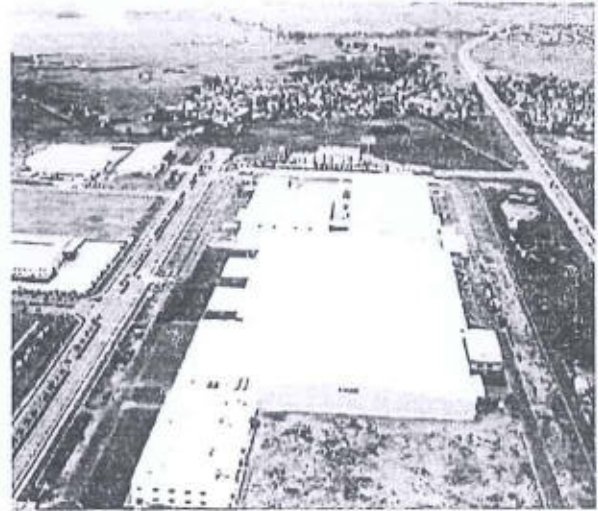
Nhà máy Canon Vị trí: KCN Quế Võ, Tỉnh Bắc Ninh Thời gian xây dựng: Đã hoàn thành
