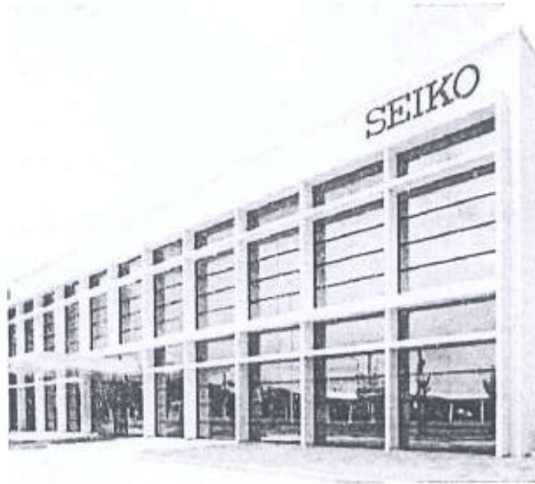
Nhà máy công nghiệp Seiko Vị trí: KCN Thăng Long II, Hưng Yên Thời gian xây dựng: 2013-2015
