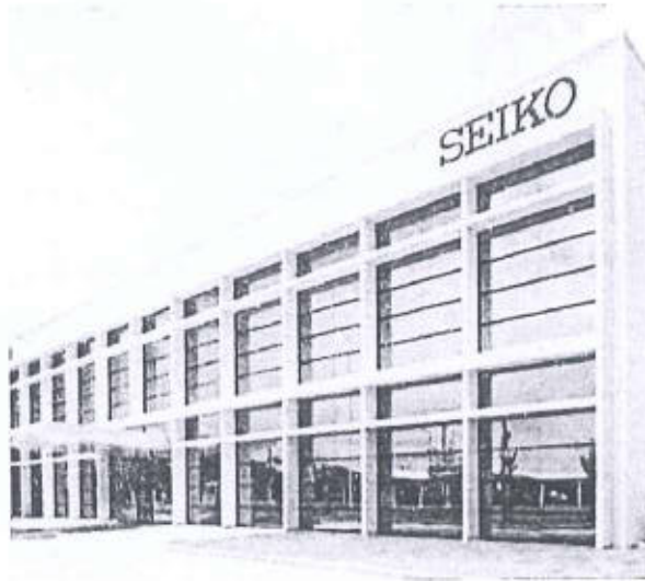
Nhà máy công nghiệp Seiko Vị trí: KCN Thăng Long II, Hưng Yên Thời gian xây dựng: 2013-2015
