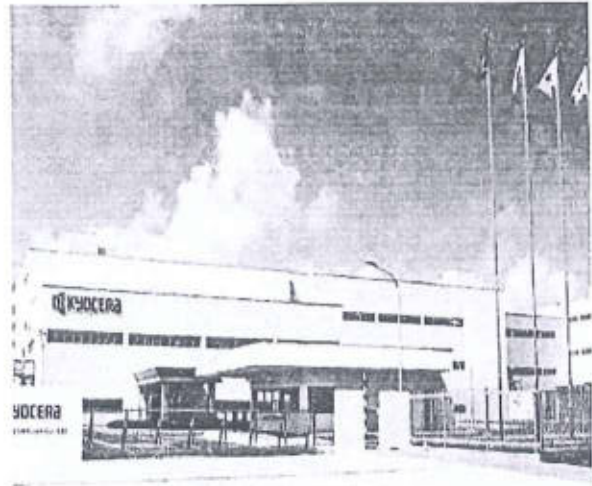
Nhà máy công nghệ cao Kyocera Vị trí: KCN Thăng Long II, Hưng Yên Thời gian xây dựng: 2012-2013
