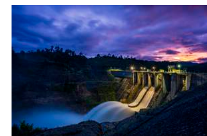
Nhà máy Thủy điện Hòa Na (Nghệ An)
