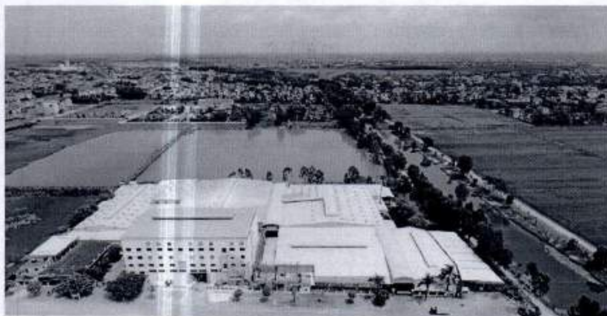
Nhà máy 1A, 1B
