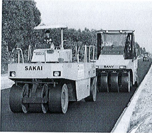
Thi công DA Đường Vành đai phía tây Đà Nẵng
