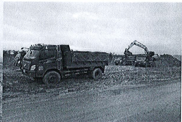
Khu TĐC Xã Hòa Phú, Hòa Vang, Đà Nẵng
